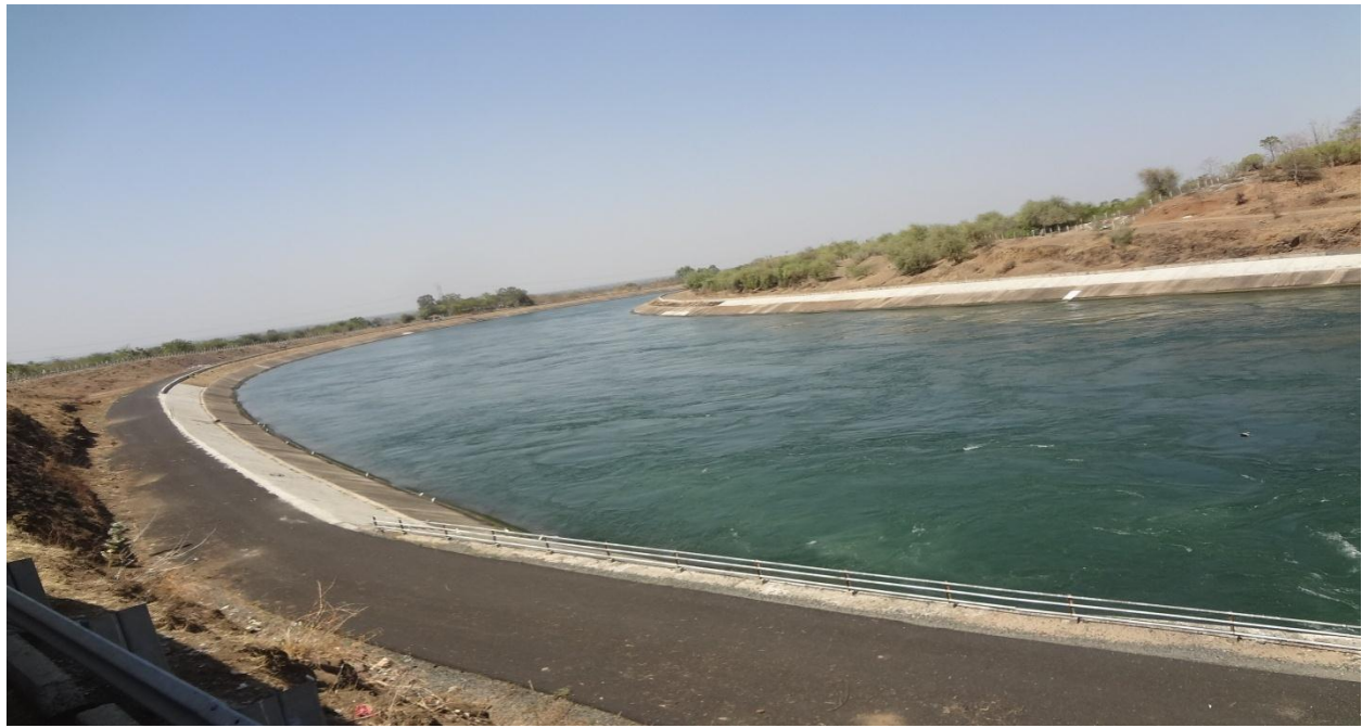
Main narmada canal
